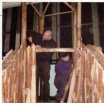
Betonowe schody kina trzeba przerobić...
